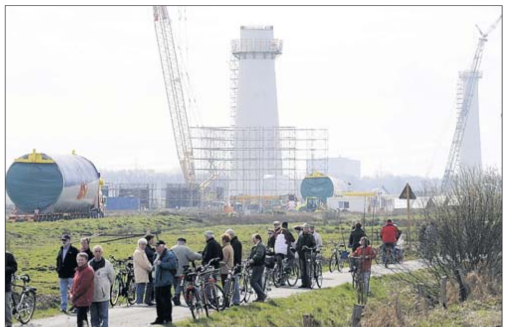
Die Baustelle: Bisher stehen Teile der Betonsöckel. Im Mai und Juni sollen darauf die Stahltürme errichtet werden, die samt Rotoren bis zu 188 Meter in den Himmel ragen sollen.
